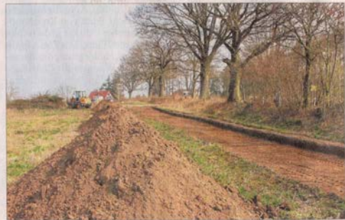
Am Rande der Seekoppel wird gerade ein Radweg gebaut. Der Aushub bleibt liegen und wird als zweiter Knickwall genutzt.
